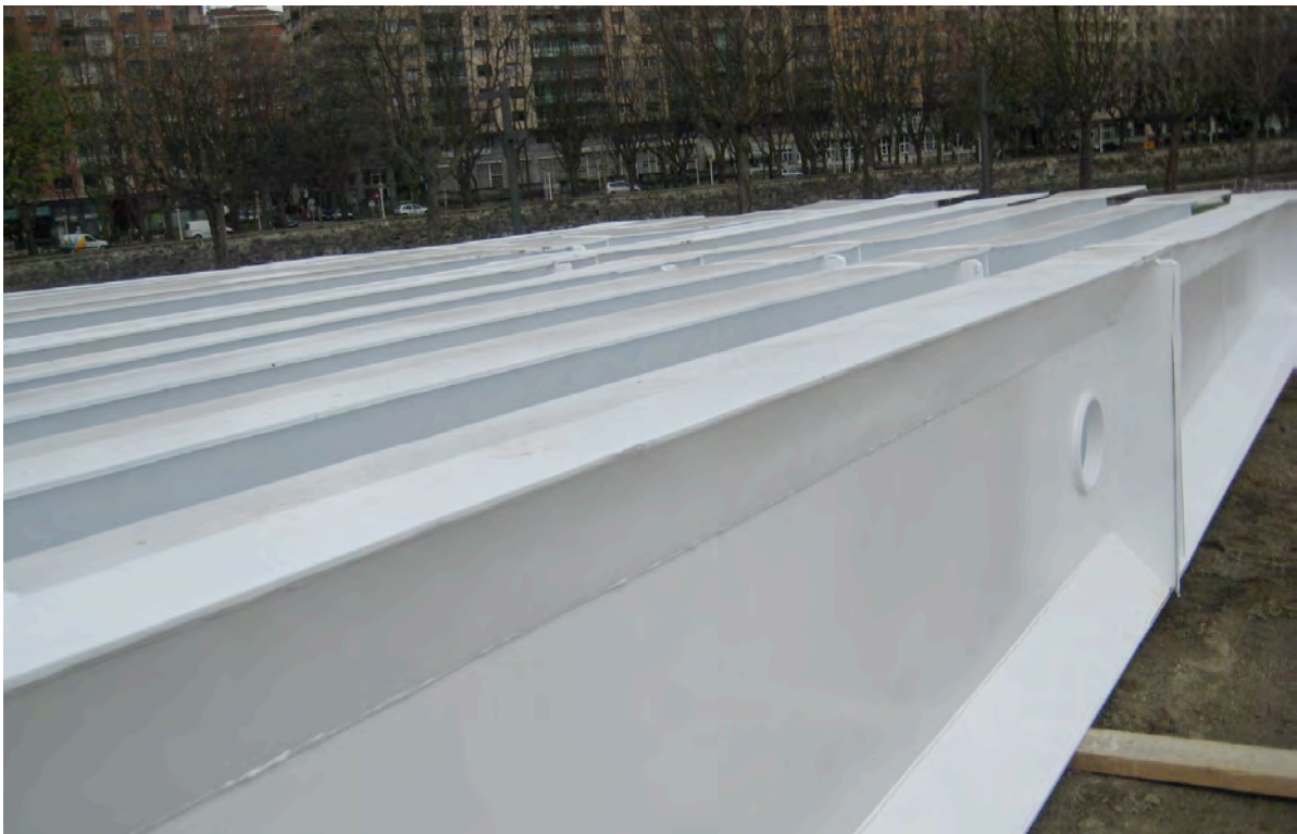
Foto. 2 Vigas transversales acopiadas en parque de montaje.
