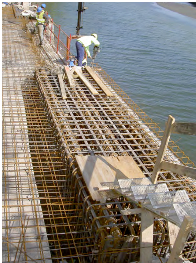
Foto. 1 Ferrallado de cabezales de apoyo en margen izquierda.
